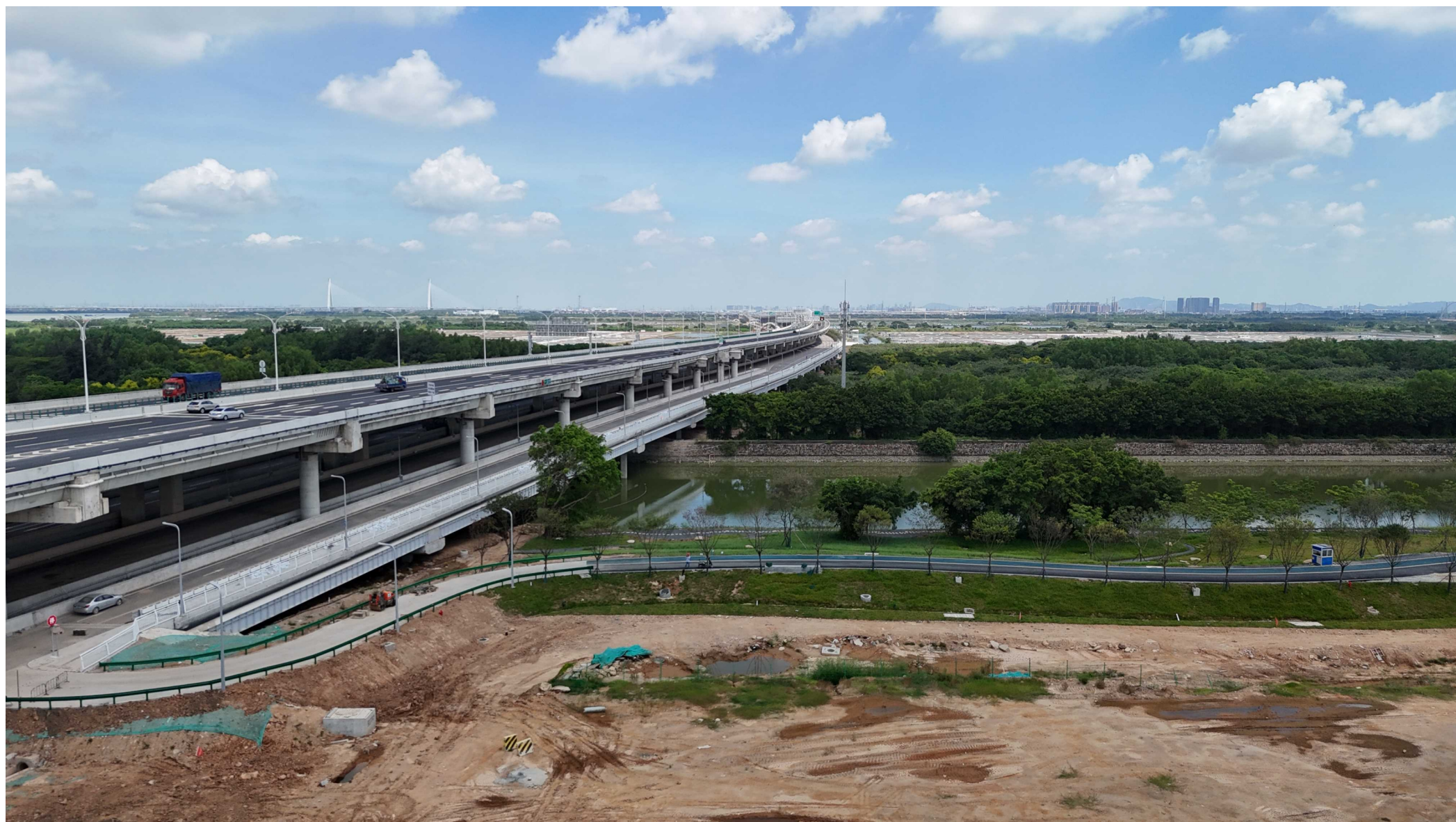
广州建筑工程监理有限公司—万环西路南延线（十六涌半至海堤段）扩建工程
