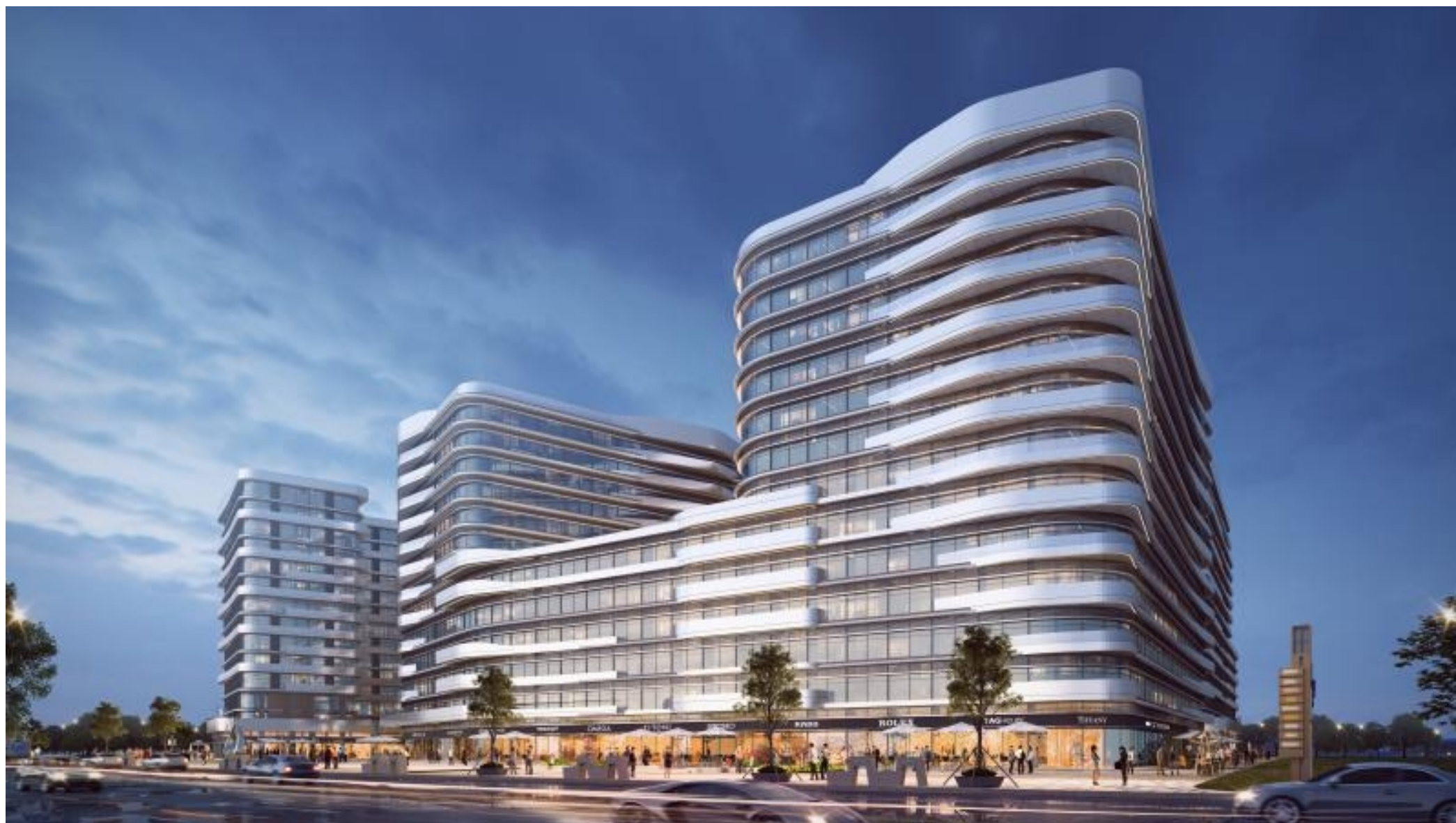
广东省广大工程顾问有限公司-天河智慧金融产业园合作建设项目监理工程
