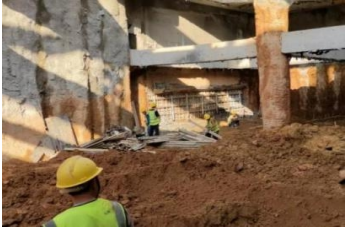
图6-逆作墙模板安装
