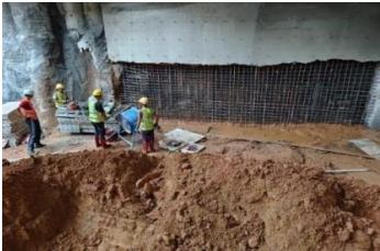
图5-逆作墙钢筋绑扎示意图
