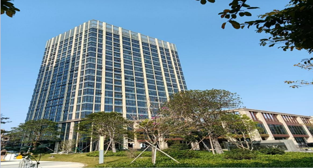
广州港设计所大院更新改造项目
