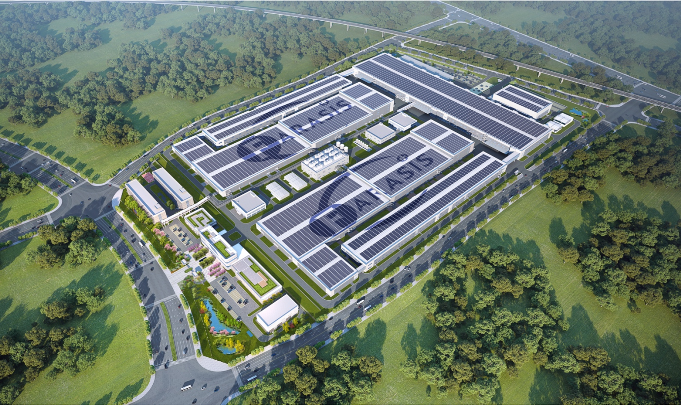
孚能科技年产 30GWh 动力电池生产基地项目
